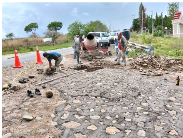
Rehabilitación de Bache calle Reforma de la cabecera municipal, mantenimiento a la toma principal de agua potable de la cabecera municipal.
