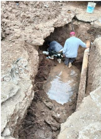
Se realizaron trabajos de reparación de la línea de conducción e instalación de válvula nueva en depósito de cabecera municipal por parte del personal de Agua Potable y Alcantarillado.
