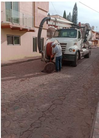
Se realizaron trabajos de limpieza de alcantarillas por parte del personal de Agua Potable y Alcantarillado, con el sistema del Camión Vector, con la finalidad de optimizar el funcionamiento de las mismas, y con esto evitar focos de infección.
